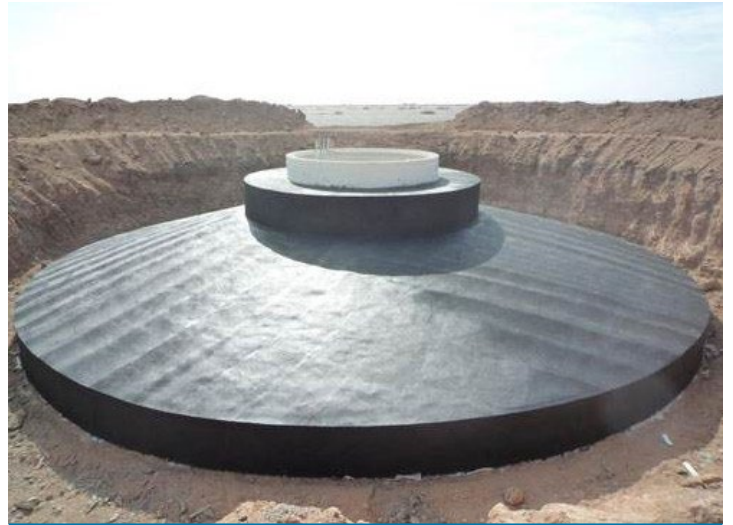
Cimientos de Turbinas. Los cimientos de las turbinas eólicas se construyen con concreto (hormigón) y acero.
