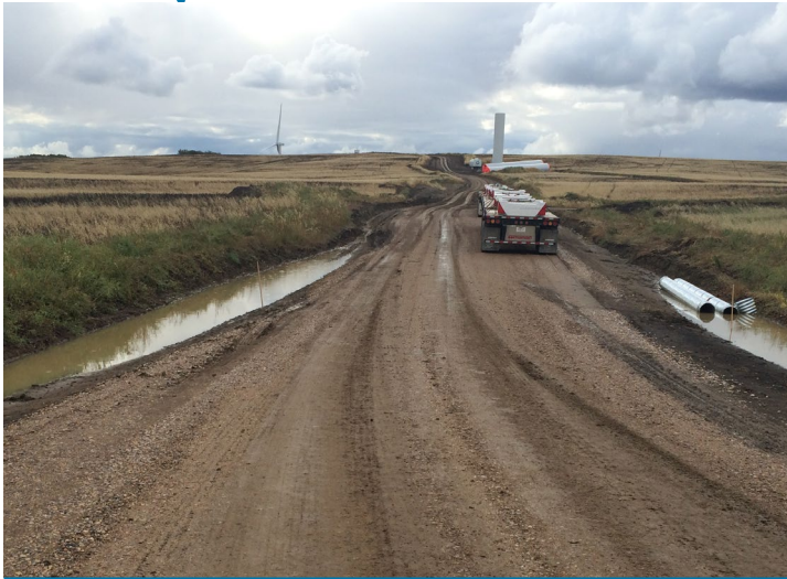
Obras Civiles. Se prepara el terreno y se inicia la construcción de caminos y las áreas de depósito.
